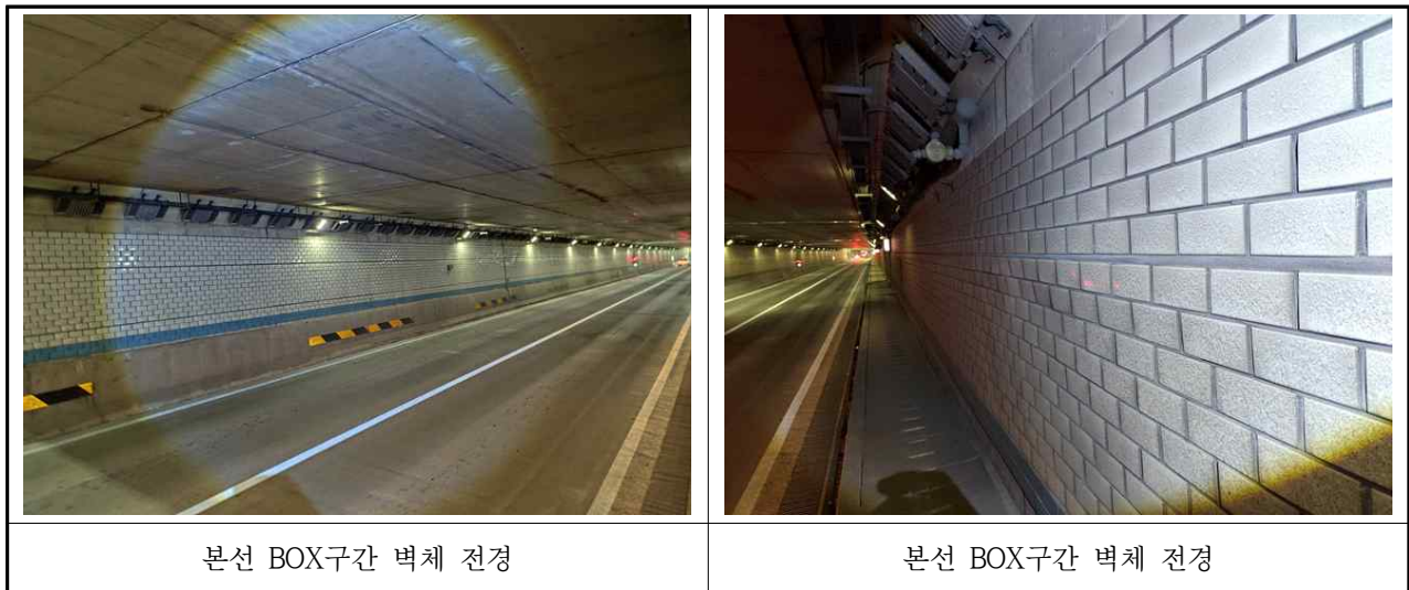
【사진 3.3.3】 BOX구간 벽체 전경
