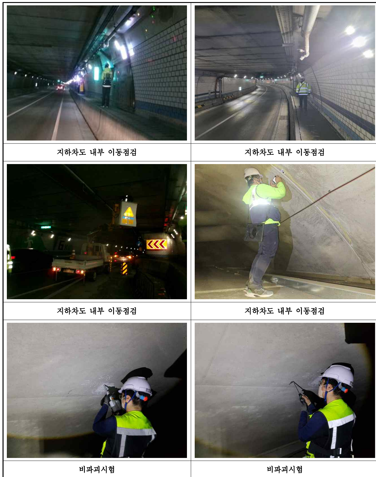
【사진 3.1.1】외관조사 전경
