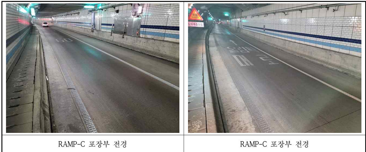
【사진 3.3.29】 포장부 전경
