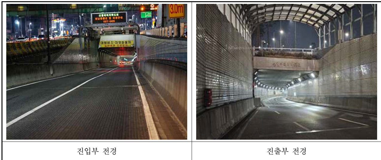
【사진 3.3.17】갯문 전경
