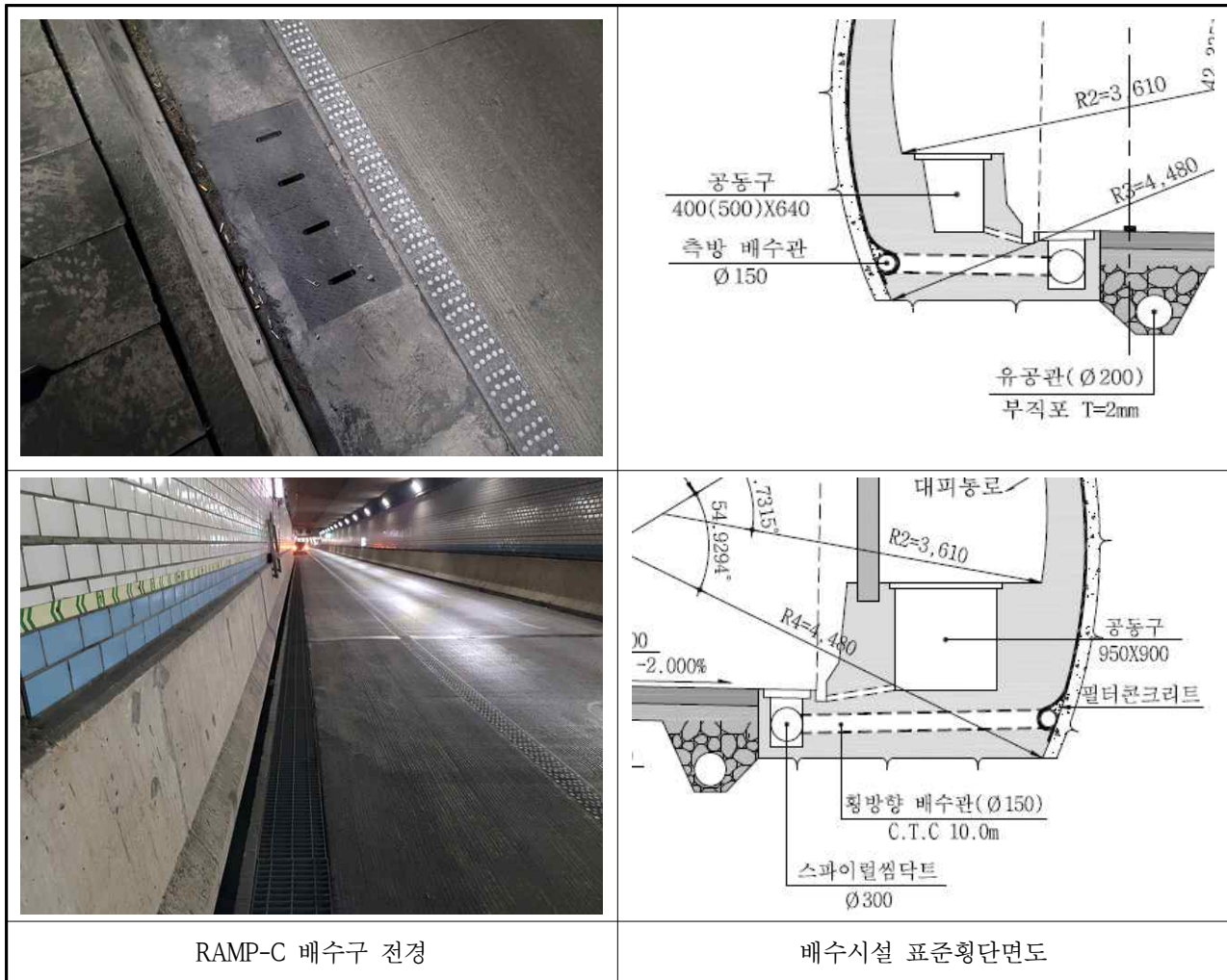
【사진 3.3.33】 배수시설 전경
