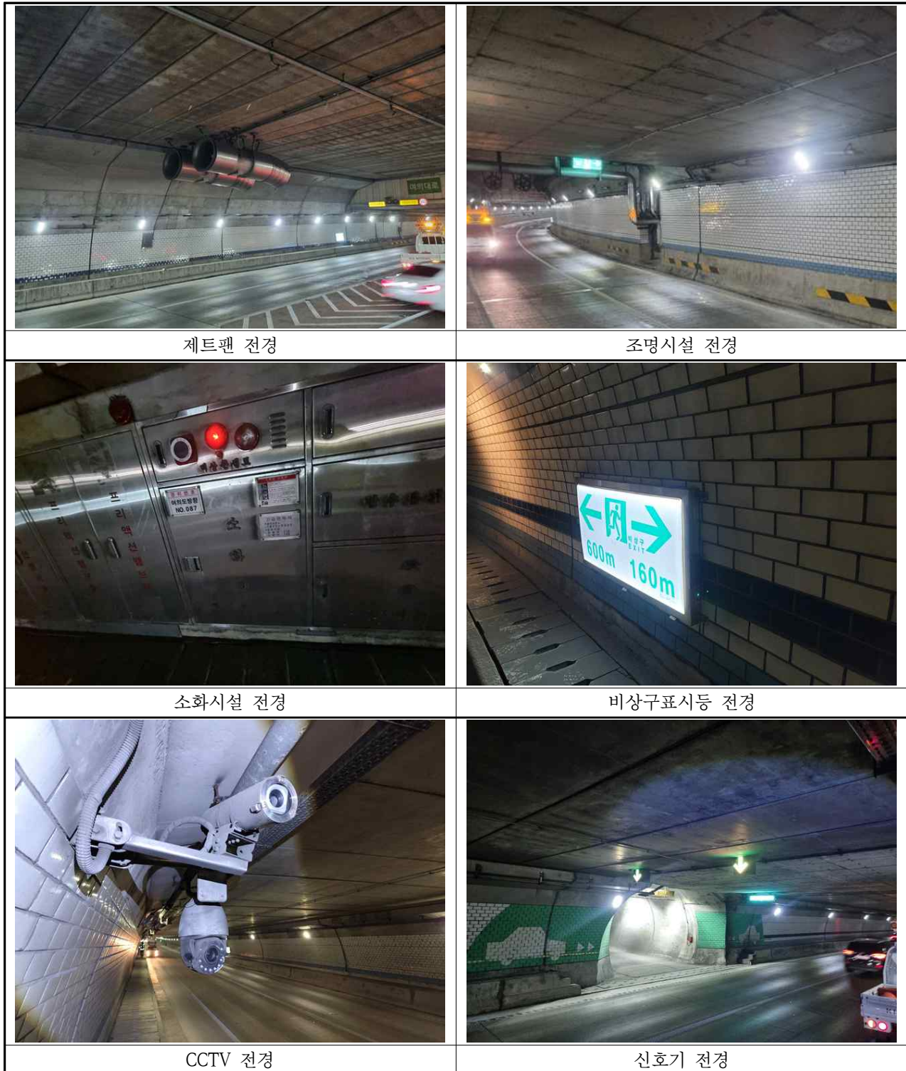
【사진 3.3.45】 부속시설 전경
