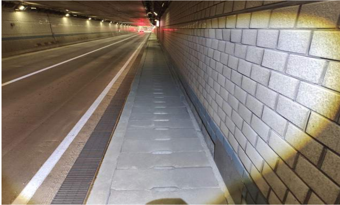
NATM구간 공동구 전경
