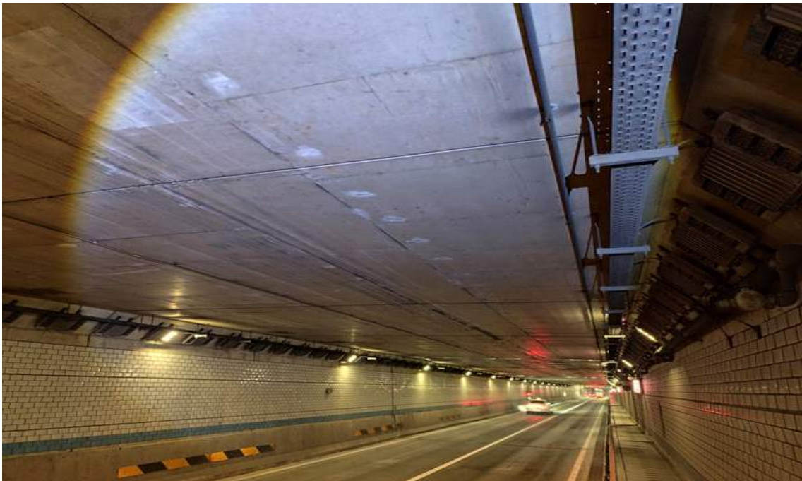
BOX구간 슬래브 전경
